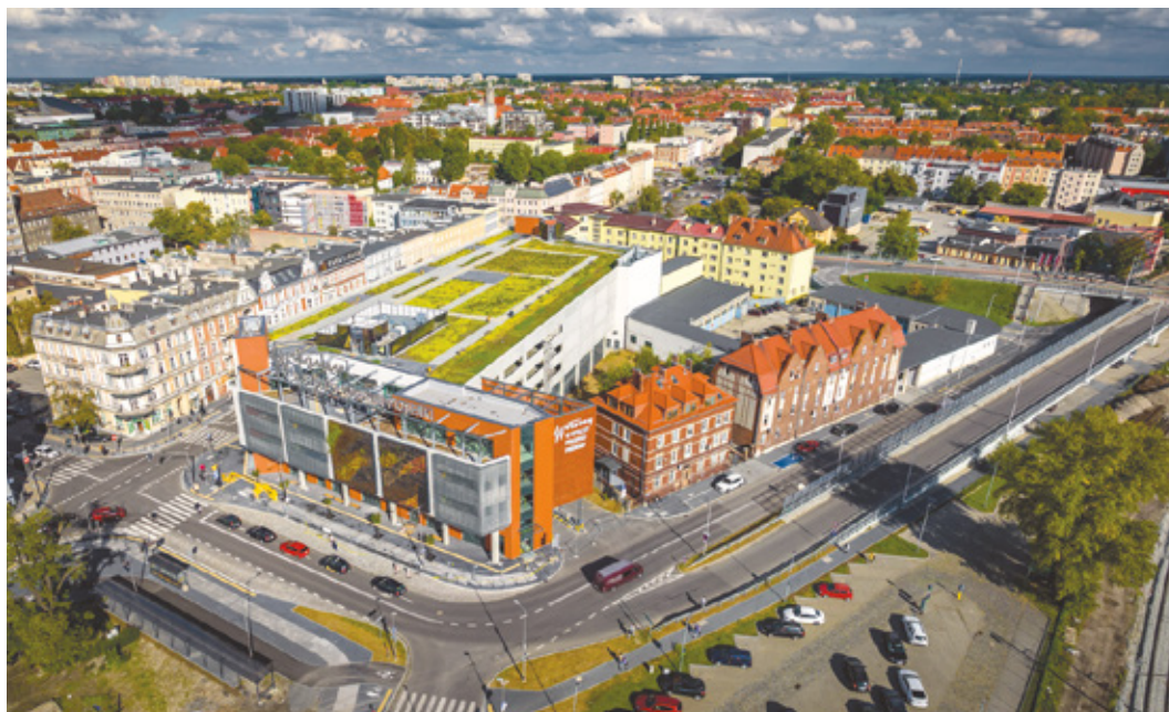
Fot. 2. Widok na centrum przesiadkowe (w trakcie budowy)
