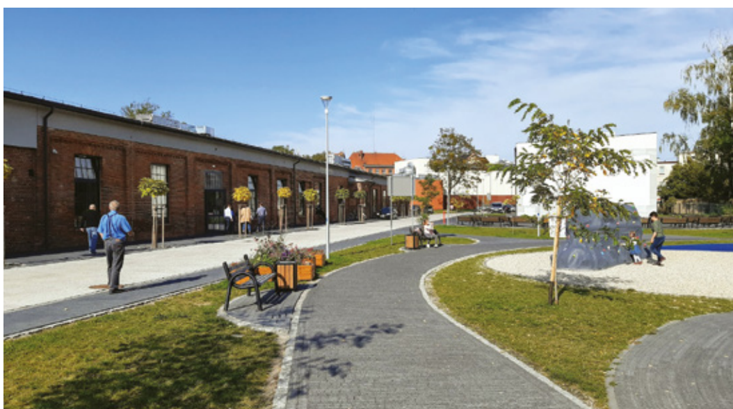
Fot. 13. Zakład Aktywizacji Zawodowej i świetlica „Parasol” przy ul. Pułaskiego w Kluczborku
