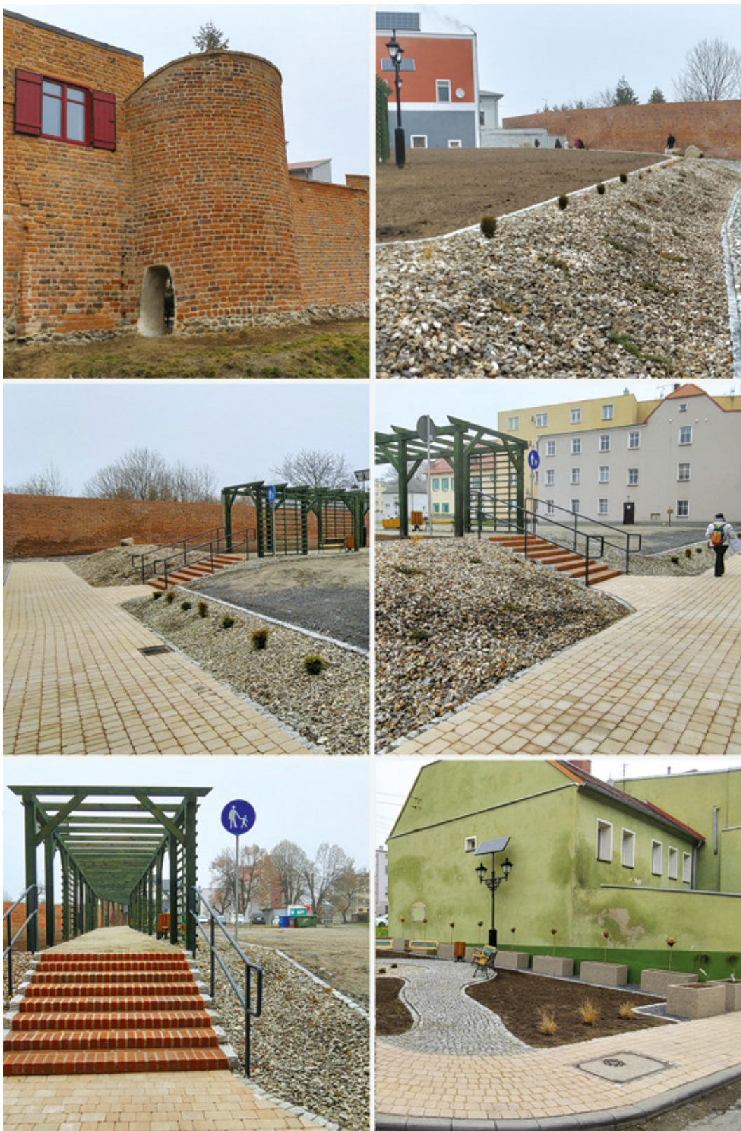
Fot. 6. Widok na różne elementy projektu Wałowa 6-8, ilustrujący funkcjonalność oraz koordynację sposobu zagospodarowania (kolorystyka, materiały) z rozwiązaniami zastosowanymi dla pobliskiego skweru, u zbiegu ulic Wałowej i Piotra Skargi
