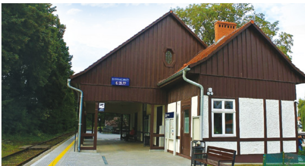
Fot. 13. Wyremontowany budynek dworca w Głuchołazach
