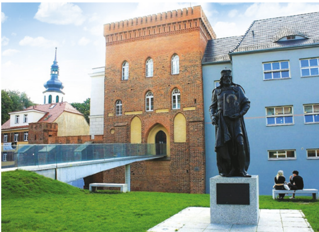
Fot. 8. Zamek Górny w Opolu po pracach restauracyjnych i uporządkowaniu otoczenia budowli
