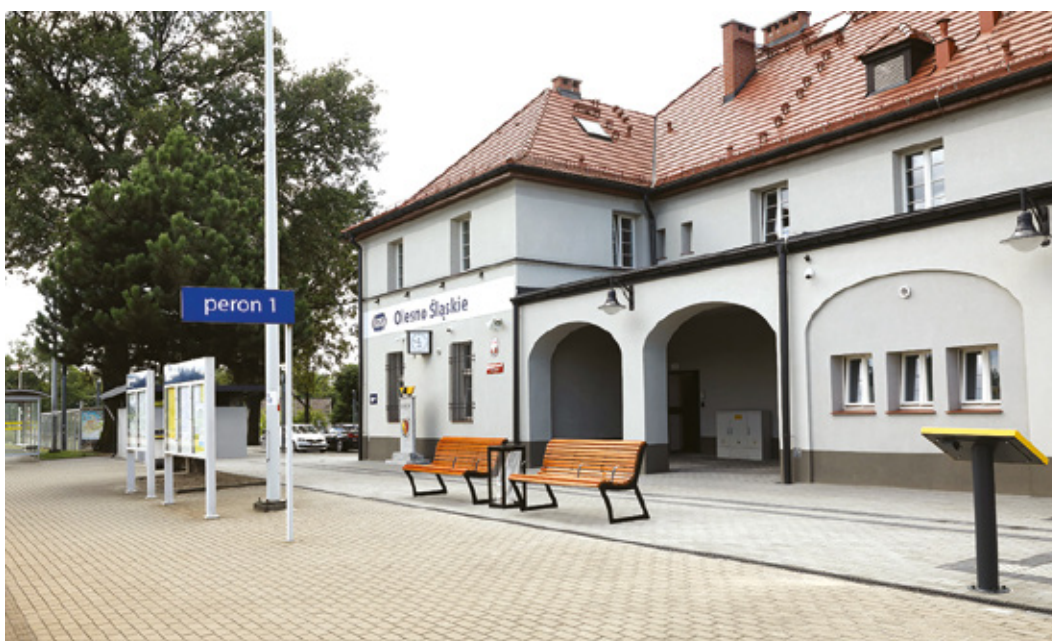
Fot. 7. Wielofunkcyjne Centrum Komunikacji w Oleśnie
