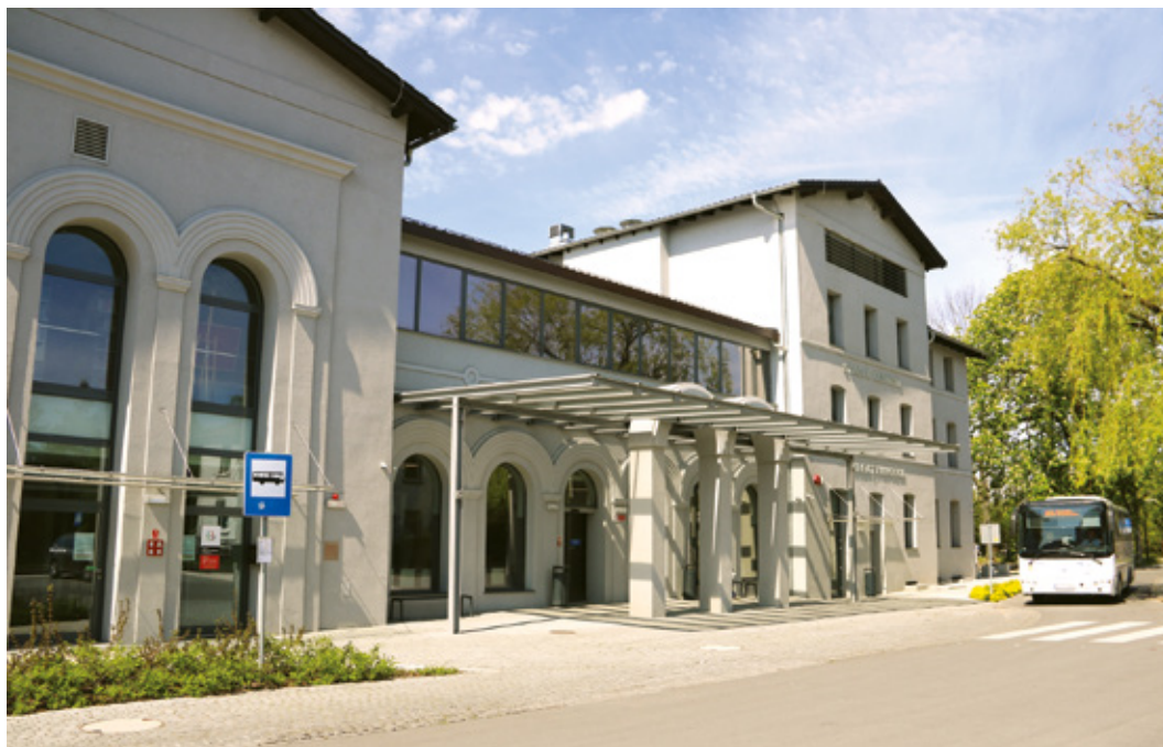
Fot. 20. Dworzec kolejowy przy placu Dworcowym w Gogolinie
