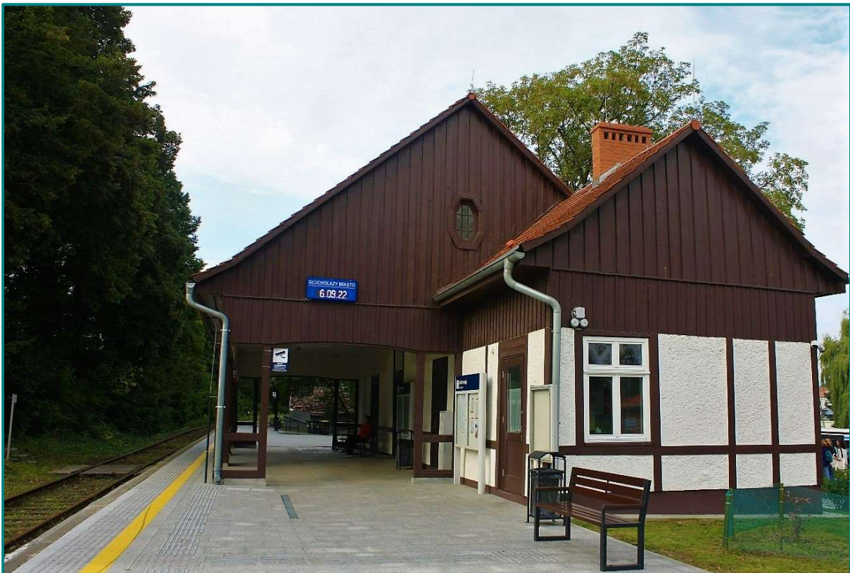
Zdjęcie 14. Wyremontowany budynek dworca w Głucholazach (fot. Edyta Tomczyk)
